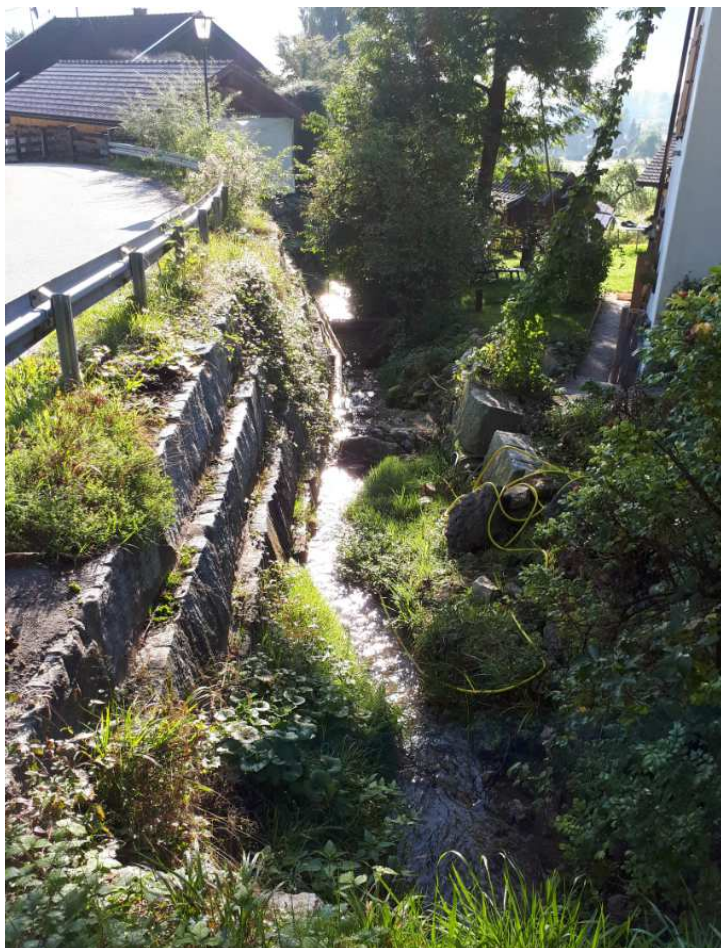
Abbildung 2: Brombergbach an der geplanten Einleitungsstelle
